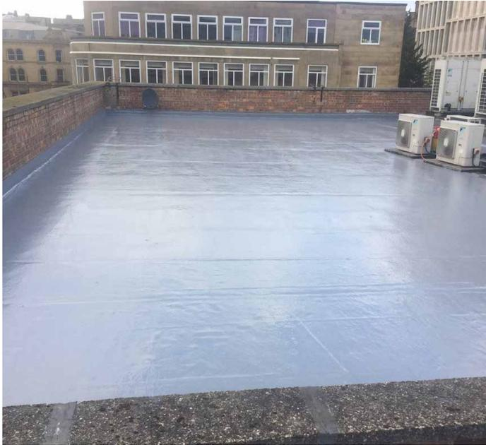
贝尔佐纳(Belzona) 3131 (WG 薄膜) 是一种冷涂型单组分涂层系统, 适用于在各种天气条件下为屋顶提供持久的修复和保护。
