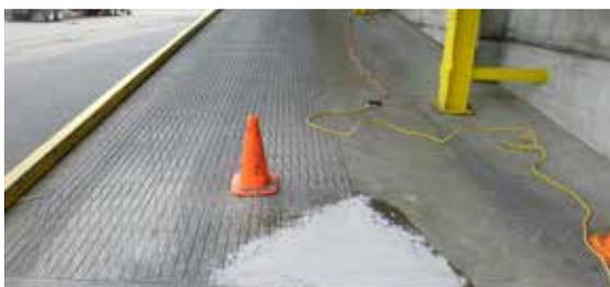
使用贝尔佐纳(Belzona) 4151 + 4111 系统来重建并抹平开裂部位
