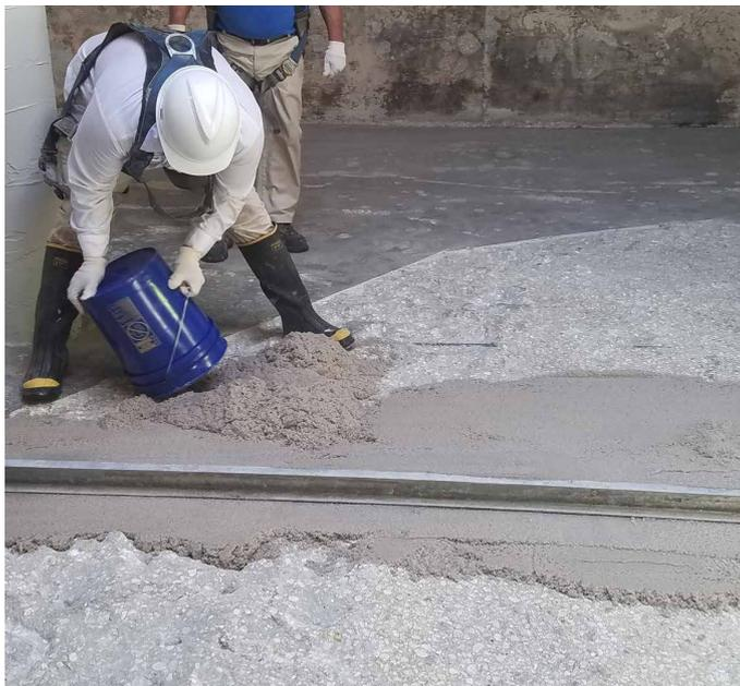
贝尔佐纳(Belzona) 4154 是一种环氧树脂基树脂材料, 适用于与市面上有售的骨料混合使用, 例如, 砂粒、石英或碎石等。它是一种经济实惠、安全且易于施工的修复解决方案。
