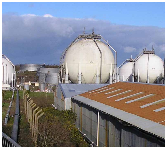
液化天然气储存球罐
